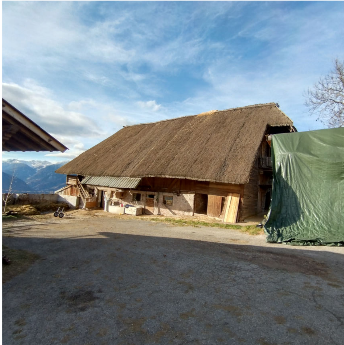
Der Hof im Jahr 2024 - Südostansicht
