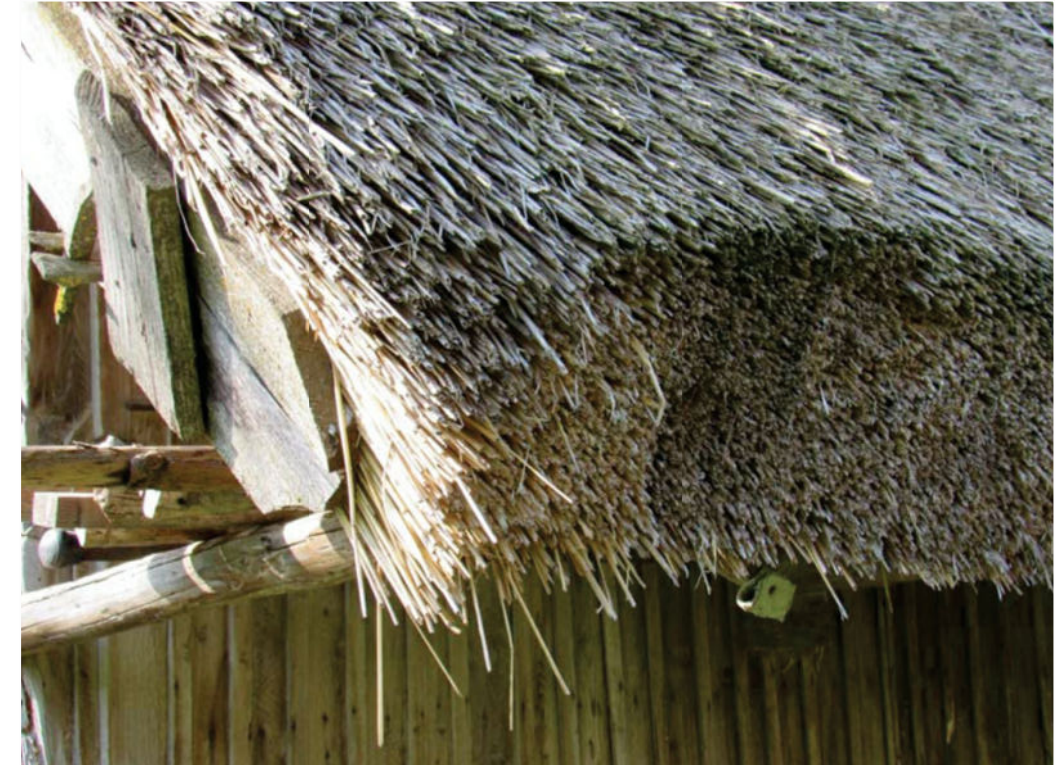
Die Strohschicht ist zwischen 25 und 30 cm stark und hat eine Einzellänge von 1,80 m;
