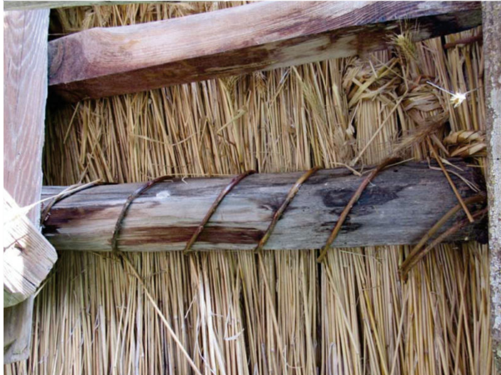
Detail zur Befestigung der Schab an den Dachlatten mit Weidenäste
